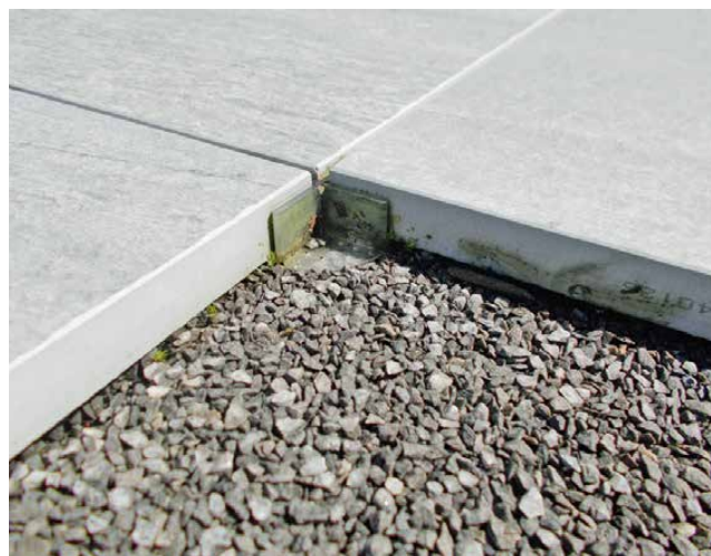
Immagine 7: Posa delle lastre da camminamento in gres porcellanato su strato di allettamento
