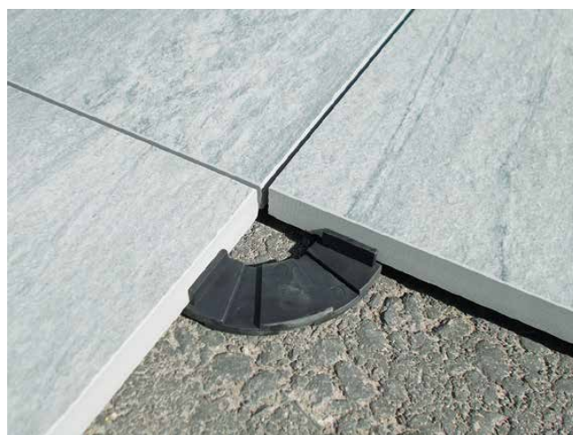
Immagine 11: Posa delle lastre da camminamento in gres porcellanato su supporti
