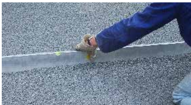
Immagine 6: Livellamento dello strato di allettamento
