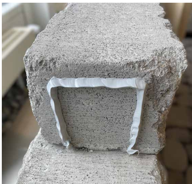
Immagine 2: Incollaggio e sigillatura delle superfici di giunzione
