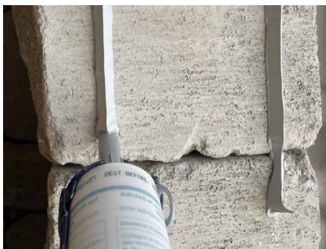
Immagine 3: Corretta orientazione dell'ugello
