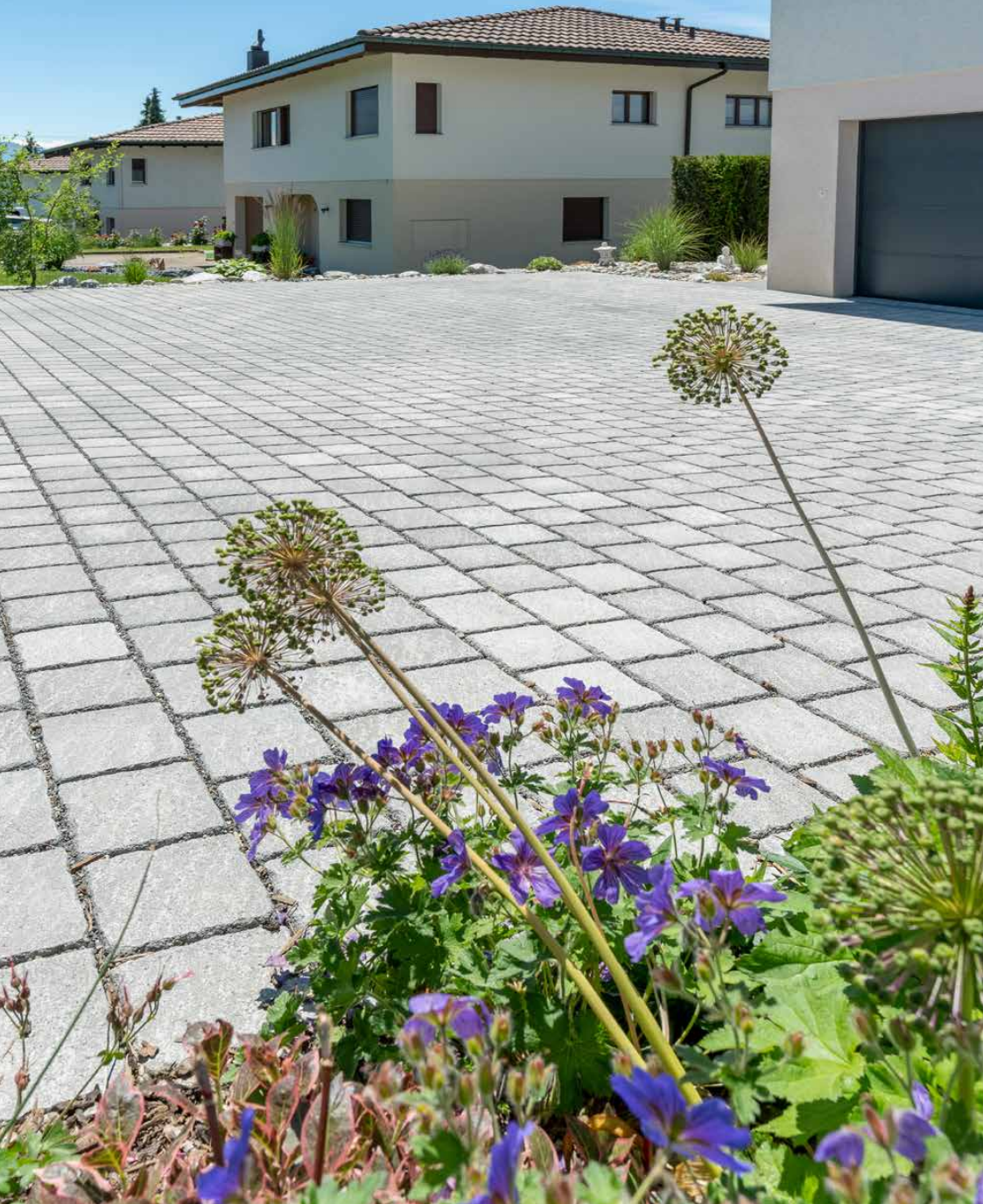
FRIEDA® DRAIN Ökosteine Kanten gebrochen in der Farbe Perlgrau
