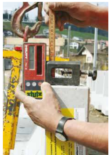
Zur Sicherheit wird die Höhenposition der Elemente sporadisch nachgemessen.
