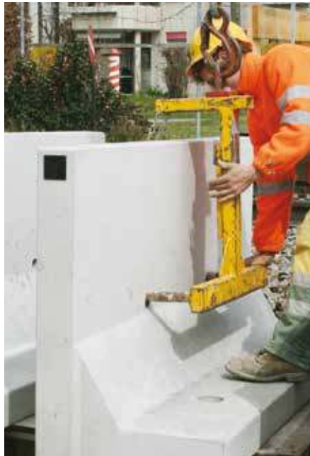
Versetzhilfe in die werkseitig eingelassenen Löcher einführen...
