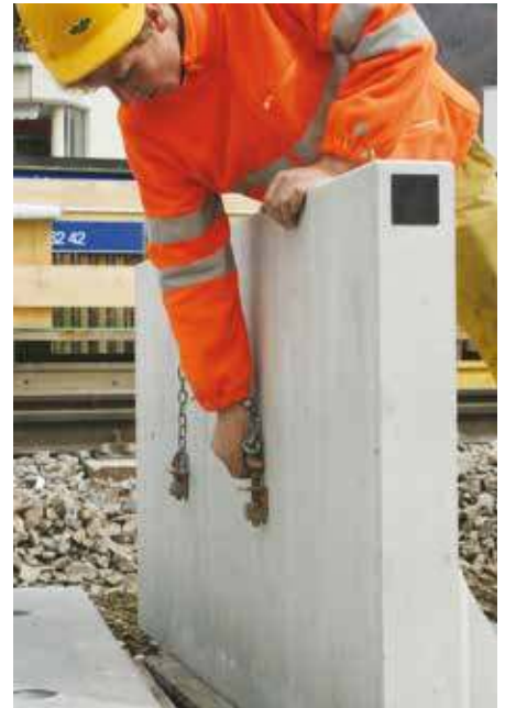
...und auf der Rückseite mit den Splinten sichern.
