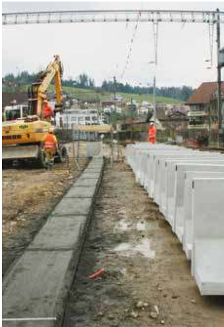
Ein exakt erstelltes Fundament ist Bedingung für das rationelle Versetzen der Perronwinkel.
