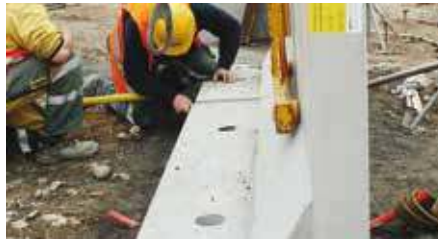
Zwei im Fuss ausgesparte Löcher ermöglichen den Einbau von Schubsicherungsseisen.
