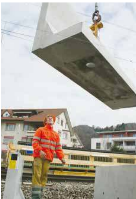
Sekunden später schwebt das Winklelement an den vorgesehenen Platz...
