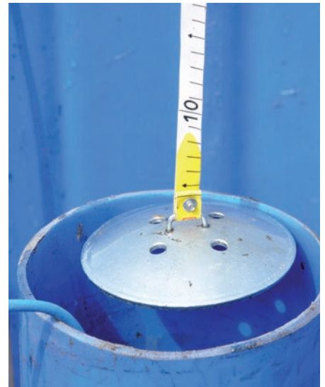
Messung des Schlammpegels mit Schlammteiler
