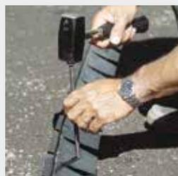
Einfaches Fixieren der PAVE EDGE®-Elemente mit Nägeln.
