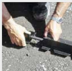
Nahtloses aneinanderfügen von PAVE EDGE® STARR und PAVE EDGE® STARRFLEX-Elementen durch die mitgelieferten Verbindungsrohre. Entfällt bei PAVE EDGE® LIGHT/LIGHTFLEX.
