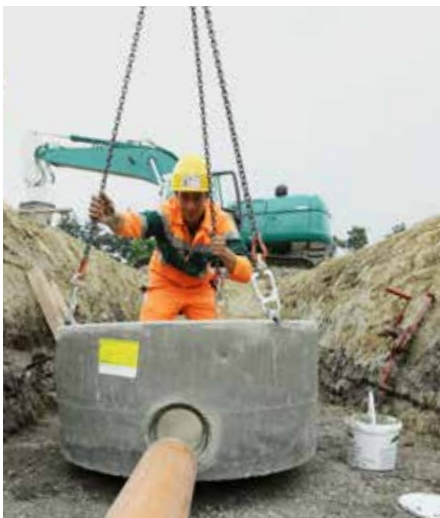
Vor dem Versetzen des CRENO Normschachtbodens muss eine höhengerechte und horizontale Sohle hergestellt werden. Geeignet sind Magerbeton, Sand, Kies oder Splitt. Im besten Fall kann der Schachtboden direkt auf das gewachsene Terrain gestellt werden.
