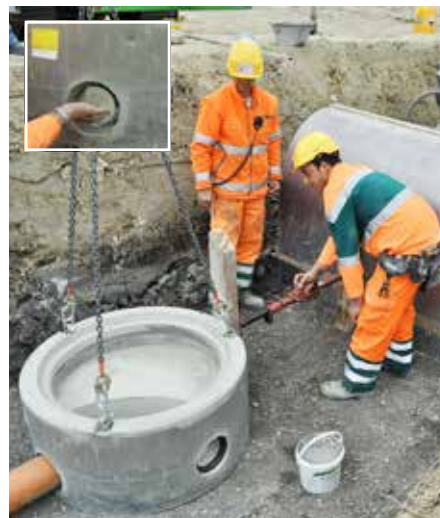
Dichtringe mit Gleitmittel in genügender Menge einschmieren. Den Schachtboden während der Versetzung nicht vollständig vom Hebegerät lösen. Den Zusammenzug mit dem Zugerät oder einer Stockwinde ausführen. Die Baggerschaufel ist dafür ungeeignet.
