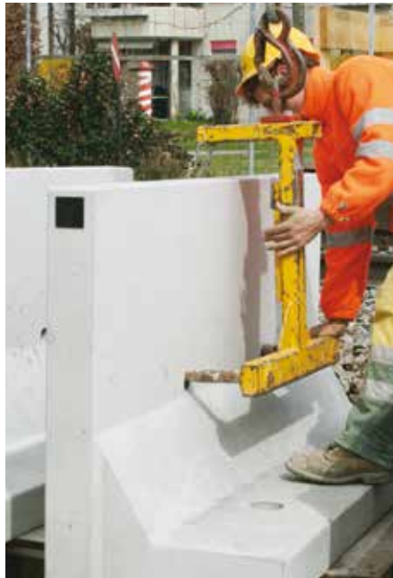
Versetzhilfe in die werkseitig eingelassenen Löcher einführen...
