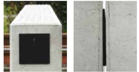
Seitliche Abstandhalter aus Gummi verhindern Abplatzungen beim Versetzen.
